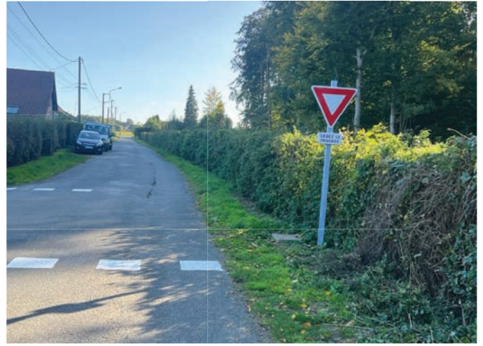
POSE D'UN «CÉDEZ LE PASSAGE» RUE DU CHÂTEAU
