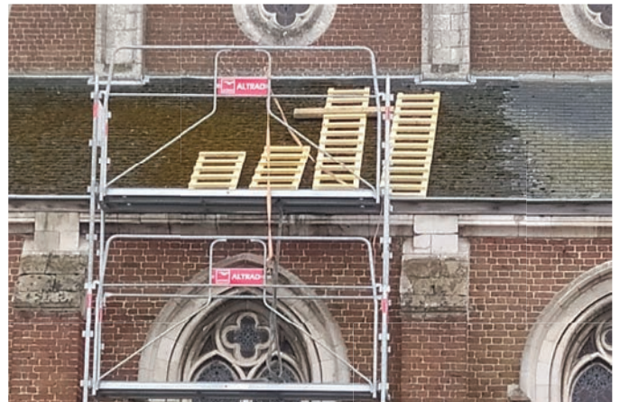
TRAVAUX SUR LA TOITURE DE L'ÉGLISE
