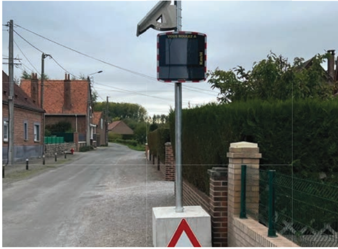
ACHAT ET INSTALLATION D'UN NOUVEAU RADAR PÉDAGOGIQUE RUE BASSE
