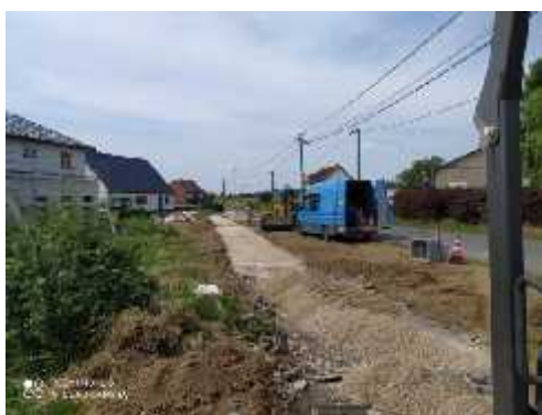
Photo prise en début de chantier
